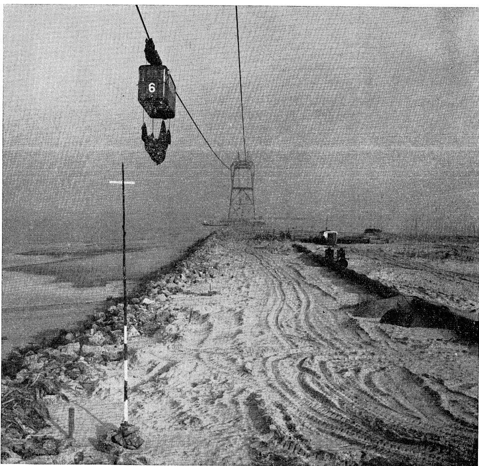
Opspuiten van het dijklichaam van de dam door de Noordelijke Geul van de Grevelingen
