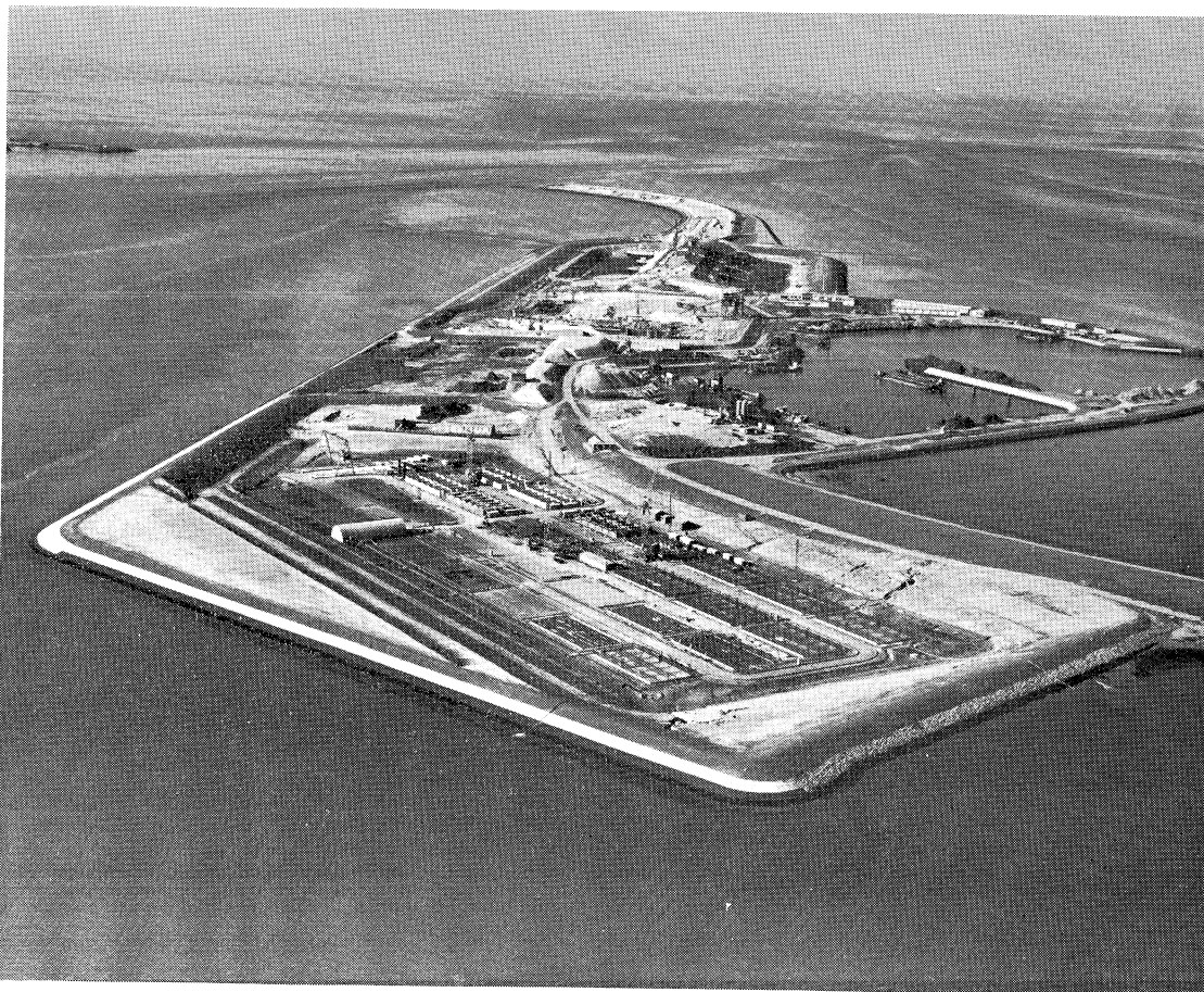
Het werkeiland met het bouwdok voor de caissons in de Lauwerszee; opname van oktober 1966
