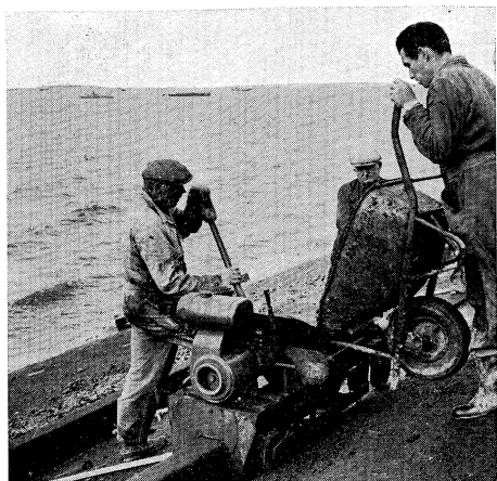
1 De nieuwe asfaltverdeel- en afwerkmachine in bedrijf
