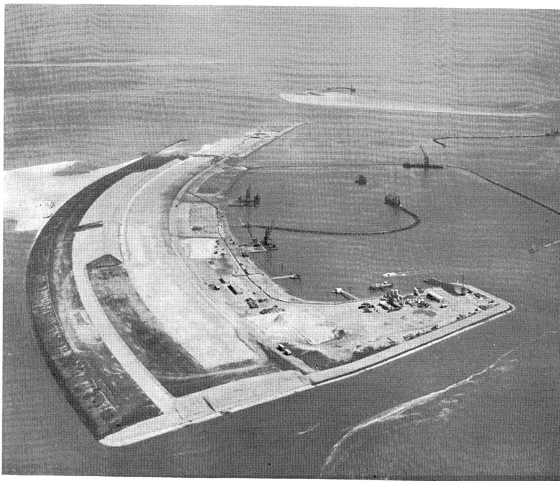
De dam over de Middelploot (voorgond) en de Kabbelaarsbank in het Brouwershavensche Gat, gezien van zuid naar noord. Opname van 1 mei 1966
