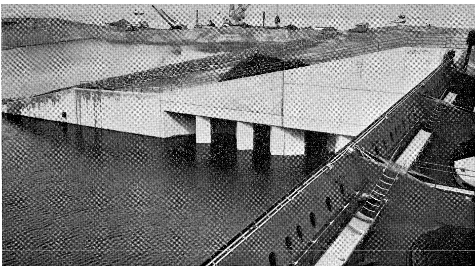
De vleugelmuur, van de sluizen af gezien
