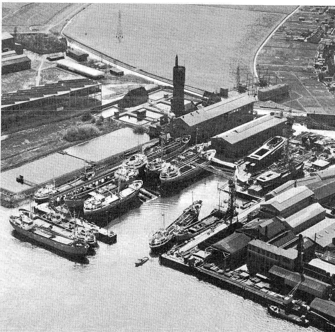
Scheepswerf met twee langshellingen voor nieuwbouw en een dwarshelling voor reparatie
