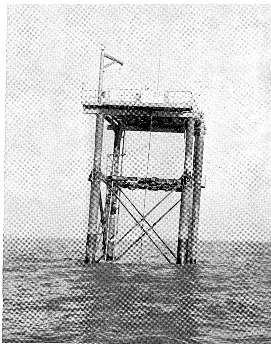
Het station Triton, scheefgezakt door de storm
